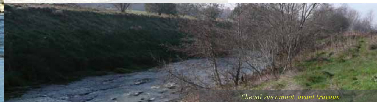
Renaturation de l'Hers à Castelnau d'Estrétefonds
