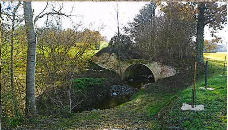
Pont mis en valeur après travaux – dec 2022
