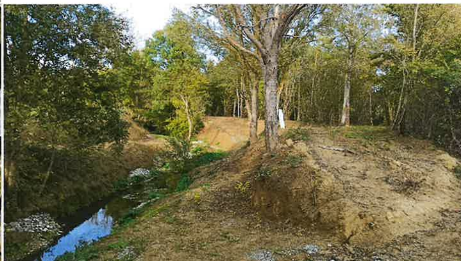
Après travaux – oct 2022
